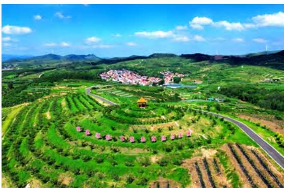
山东省淄博市沂源县一体化推进水土保持工程
