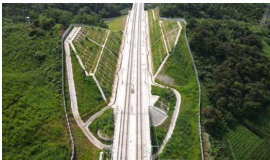
沈阳至长白山高速铁路抚顺段路堑边坡综合防治
