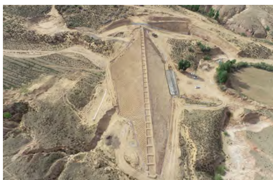
内蒙古自治区鄂尔多斯市达拉特旗淤地坝工程
