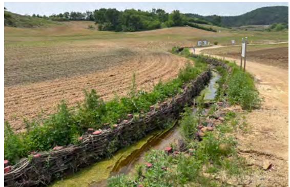
辽宁省抚顺市抚顺县 东北黑土区侵蚀沟治理工程
