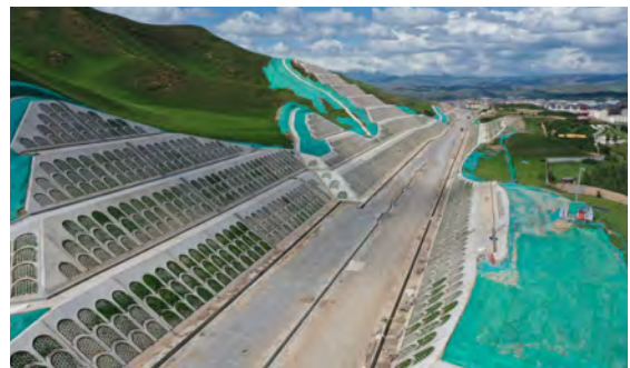
新建铁路西宁至成都路基边坡综合防治
