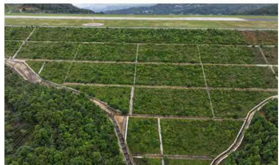
云南省临沧凤庆通用机场边坡综合防治
