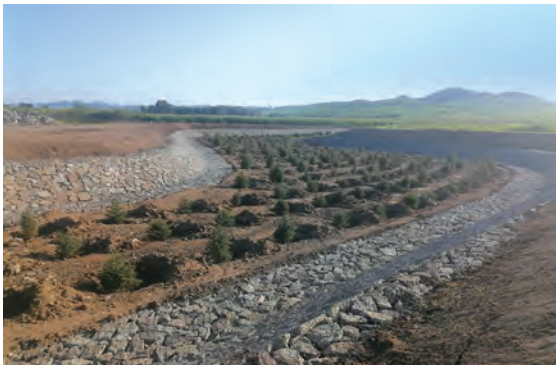
内蒙古自治区兴安盟突泉县 东北黑土区侵蚀沟治理工程
