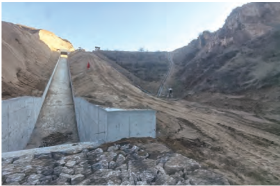
山西省忻州市偏关县 病险淤地坝除险加固工程
