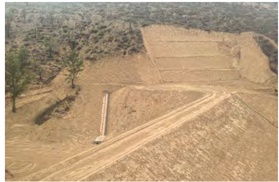
陕西省榆林市横山区 病险淤地坝除险加固工程
