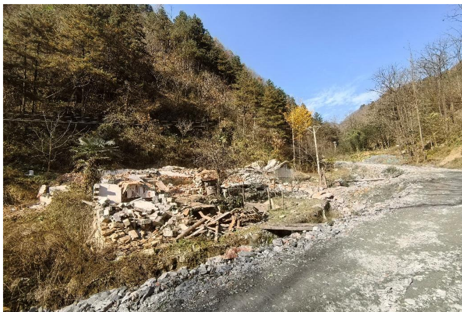
天竺山一号隧道2号横洞弃渣场民房拆迁后影像
