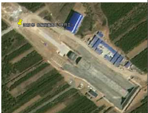
北榆隧道进口
