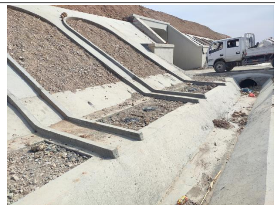
路基边坡排水沟
