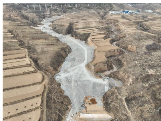
恒山隧道出口与5号斜井弃渣场
