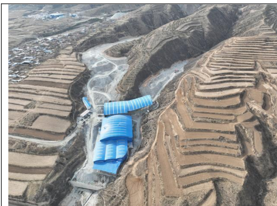
恒山隧道4号、5号斜井弃渣场
