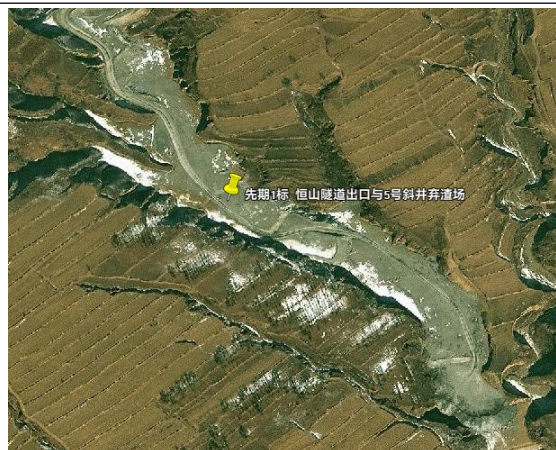
恒山隧道出口与5号斜井弃渣场遥感影像
