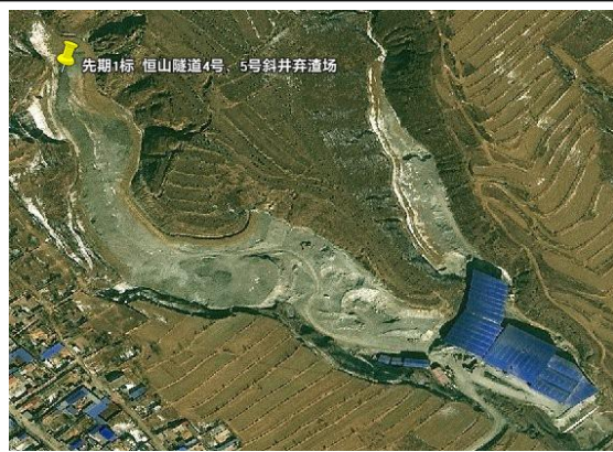
恒山隧道4号、5号斜井弃渣场遥感影像
