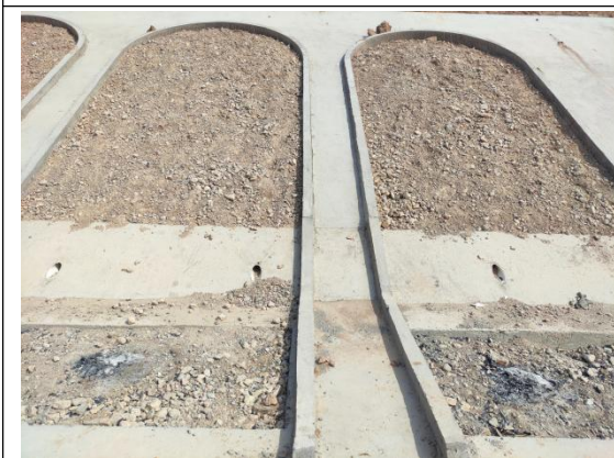
路基边坡急流槽
